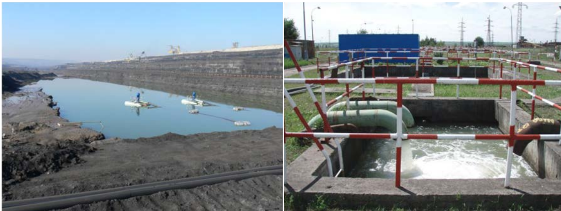
Obr. 5.55: Jímka hlavní čerpací stanice a jímka úpravy důlních vod Vršany
