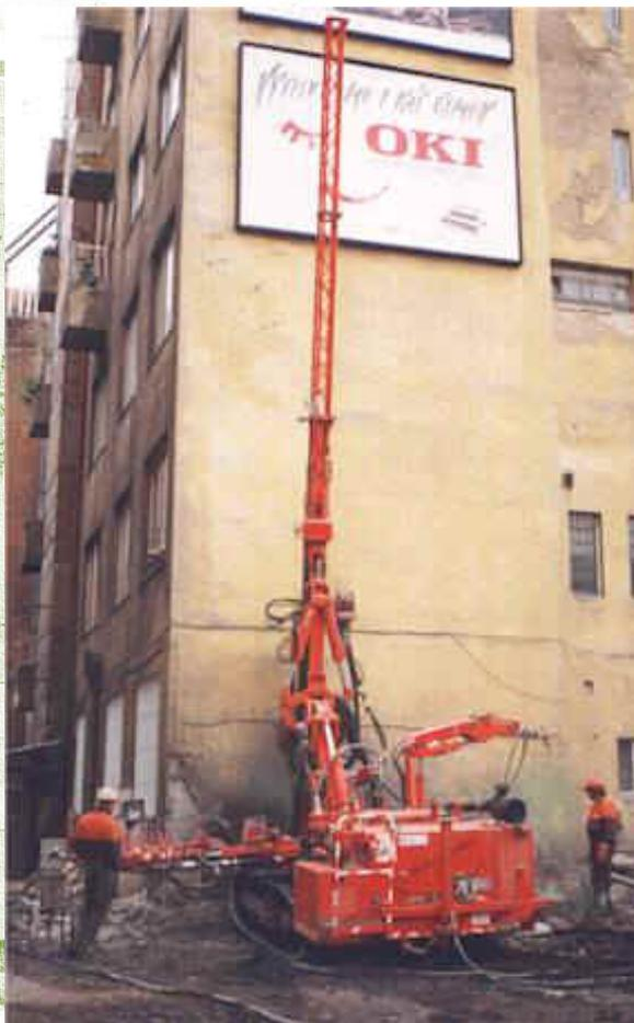
*Příklad podchycování objektu pomocí mikropilot*
