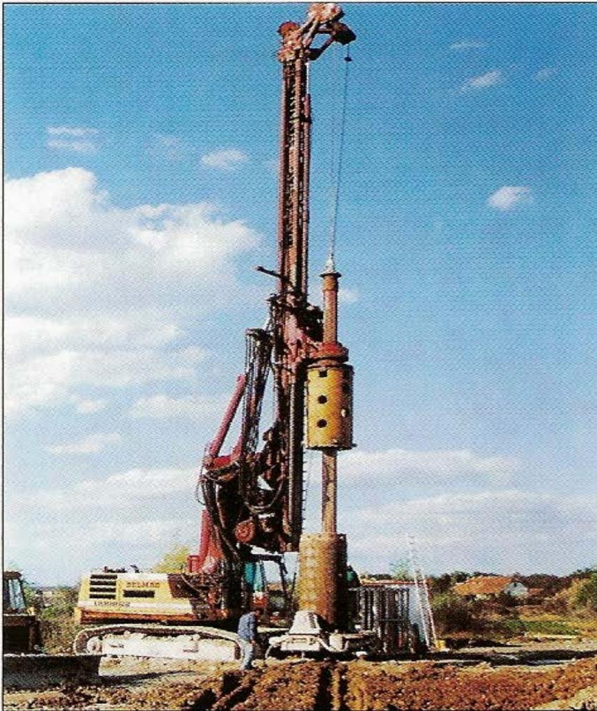
Bohranlage DELMAG RH
