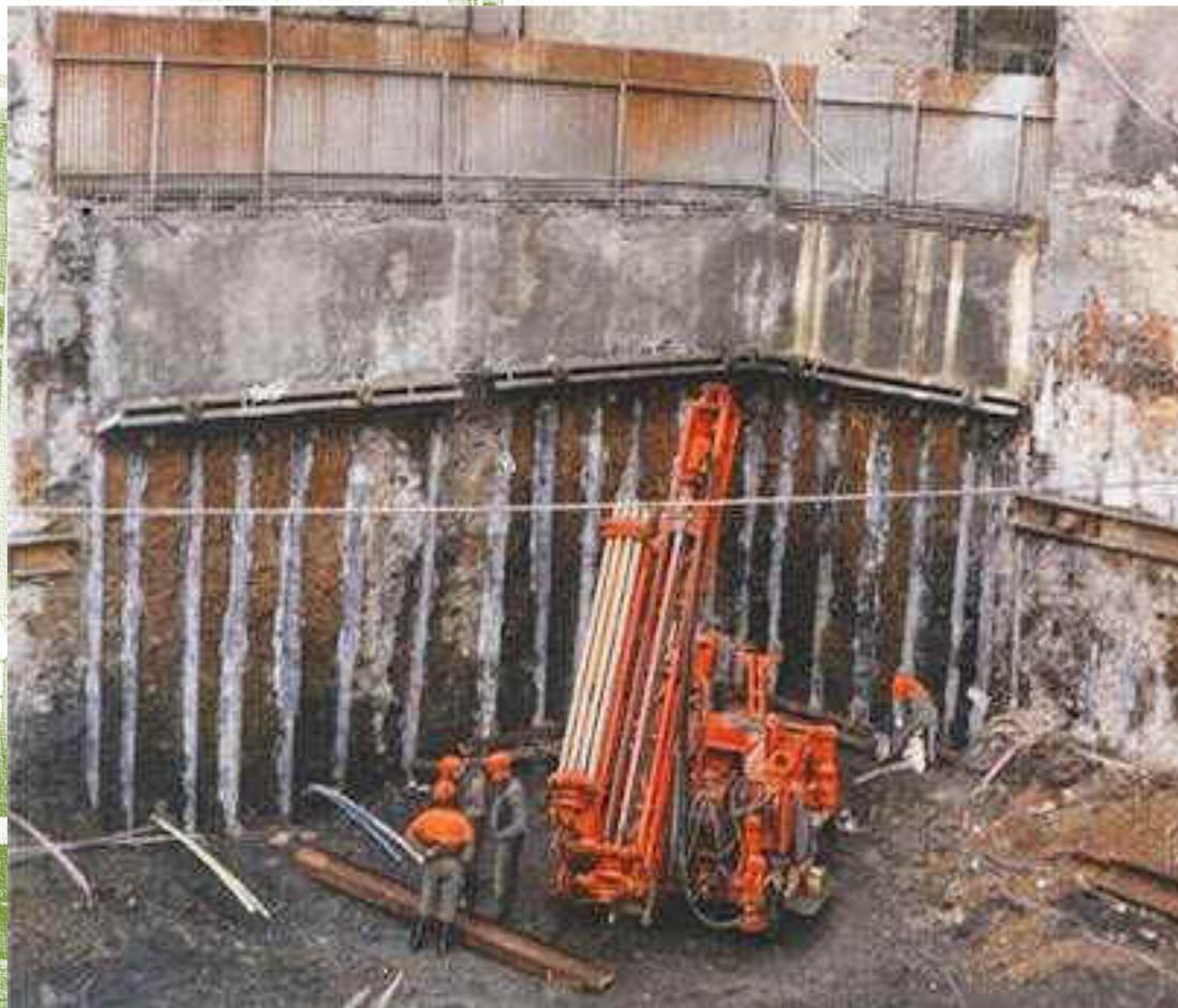
*Příklad pažení stavební jámy mikropilotovou stěnou*
