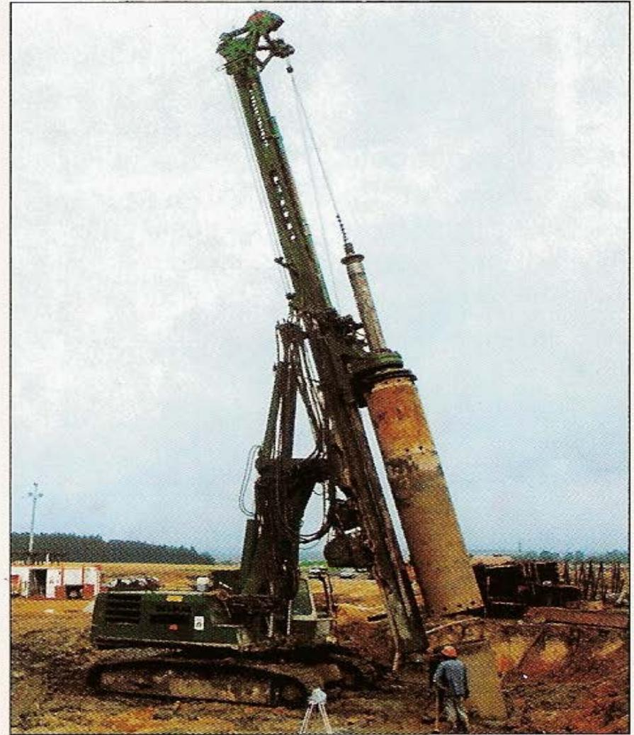
Bohranlage DELMAG RH 1413 bei dem Abteufen von schrägen Bohrungen für Pfähle
