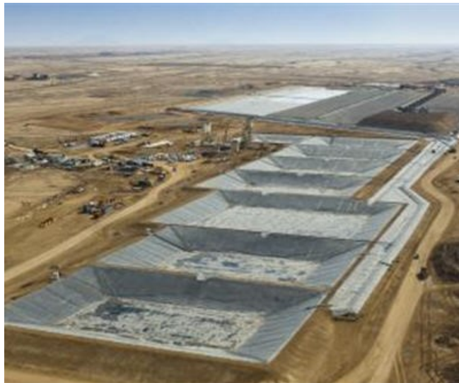
Obrázek 1 – Loužení na haldách (Chile; zdroj mining.com)
