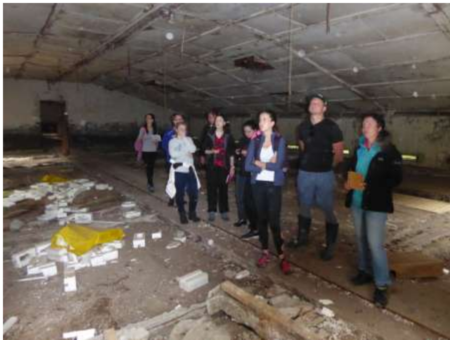
Fotografie 9: Zrušený vepřín v Hořejších Kunčicích se stal pro studenty modelovým objektem, pro který měli vypracovat možné návrhy budoucího využití.
